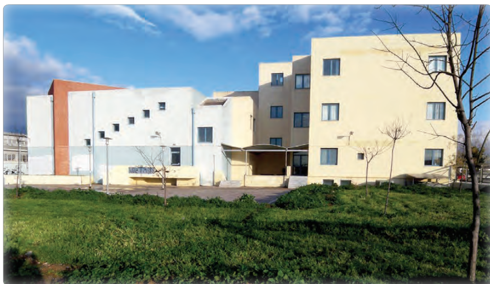
■ Κτήριο Τμήματος ΜΧΠΠΑ: Νότια όψη
